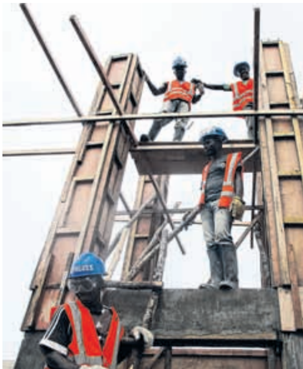
Auf der Baustelle in Liberia war viel einfache, harte Handarbeit gefragt, so etwa bei der Schalung des Wasserturms (links), aber auch bei allen verschiedenen Materialtransporten (rechts).
